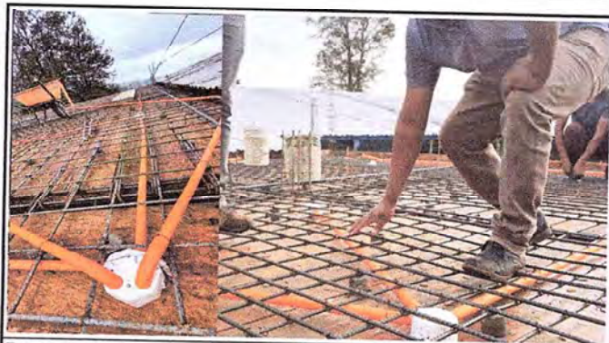
Foto 3: Instalacion de energía electrica finalizada.
