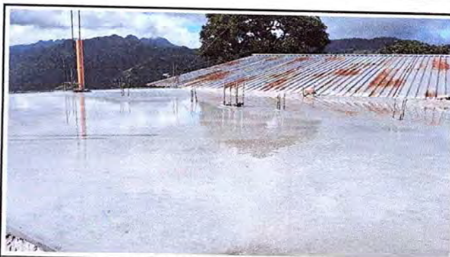
Foto 4: Impermeabilización de losa finalizada al 100%. A espera de colocacion de dos tinacos de 2500 litros.
