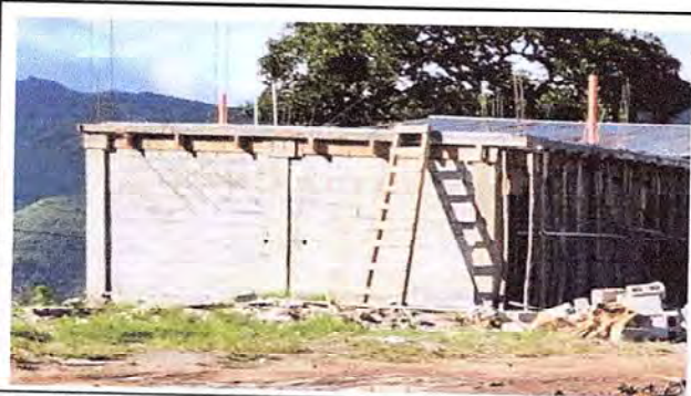
Foto 5 Vista Actual de mejoramiento de pared de los baños.
