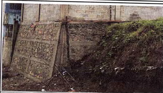
Foto 2: Vista final del muro de contención, perimetral, y como base para colocacion de cisterna para almacenamiento de agua.
